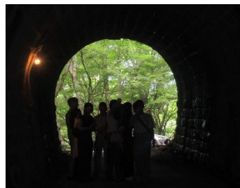
旧天城トンネル
